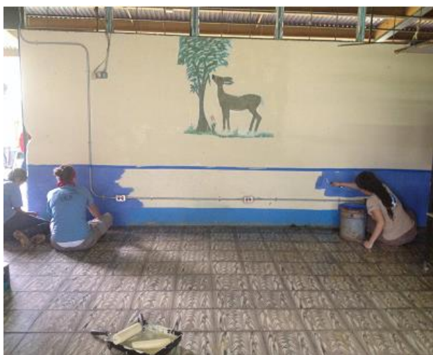
Mejoras a la infraestructura de las escuelas.
