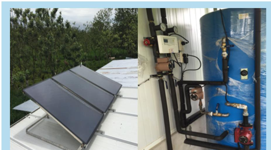
Figura 11. Sistema solar termosifónico forzado híbrido con sistema auxiliar de gas LP implementado en la planta procesadora de lácteos San Bosco.
