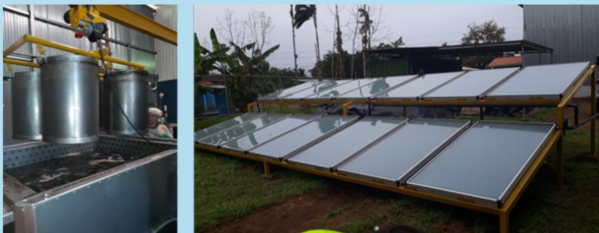
Figura 18. Sistema térmico solar híbrido forzado instalado en la planta procesadora de la Asociación de Productores de Pimienta de Sarapiquí para el escaldado de la pimienta verde.
