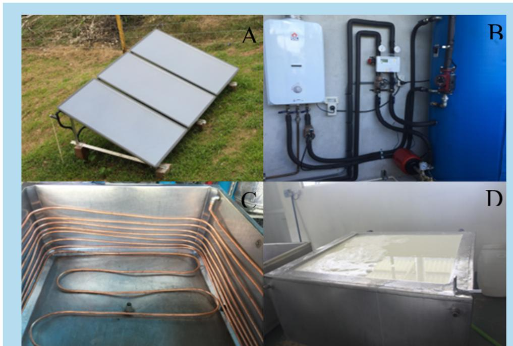
Figura 8. Detalle del sistema solar forzado híbrido con gas LP implementado en la planta procesadora de lácteos LLAFRAK. (A) Sistema de colectores solares, ubicados sobre el suelo, (B) tanque para el almacenamiento y sistema de control de temperatura del agua, (C) sistema de flujo del agua caliente (serpentines) para el intercambio de calor en la marmita recubierta (D).
