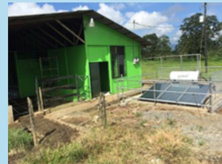
Figura 6. Sistema solar termosifónico híbrido implementado en la lechería de la Escuela Técnica Agrícola e Industrial (ETAI) en Santa Clara de San Carlos.
