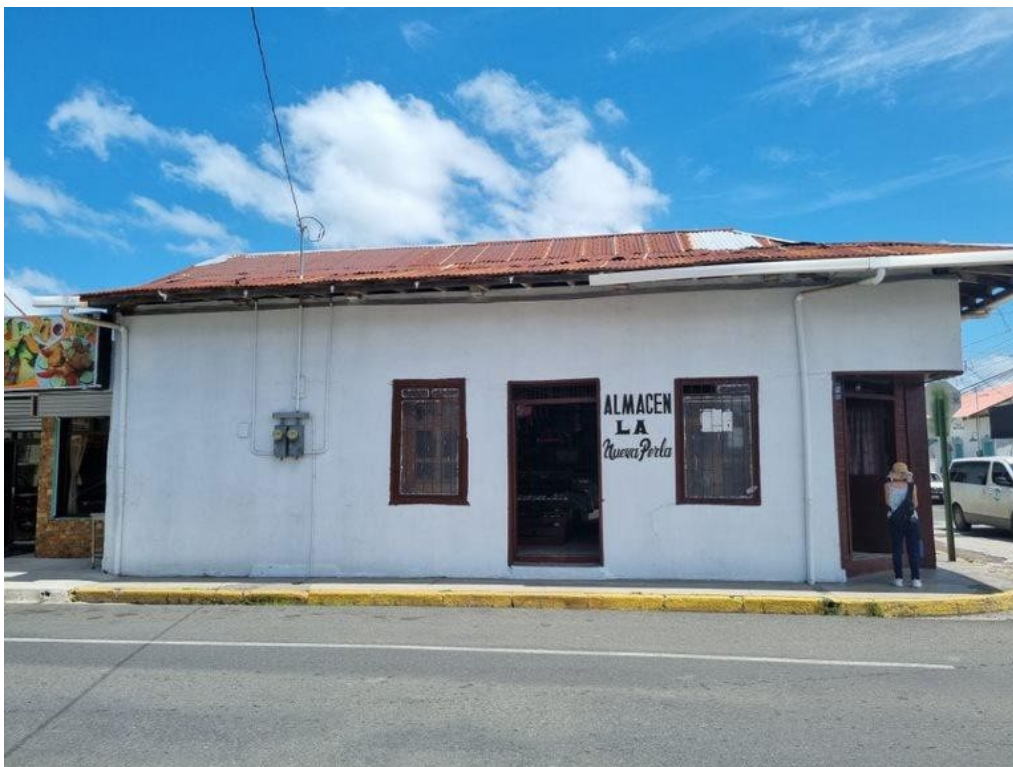
Foto: fachada de casa patrimonial registrada en taller sobre diagnóstico de recurso patrimonial en el Centro Histórico de Liberia realizado por estudiantes y profesores del ITCR. 26 y 27 de agosto.
