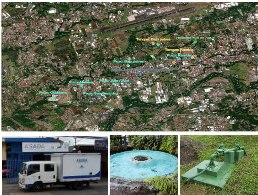
Figura 8. Infraestructura de suministro de agua potable
