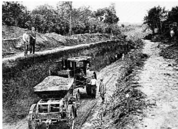
Construcción del camino de La Uruca, 1922. Tomado de: www.guiascostarica.com
